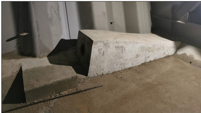
8. ábra: Csúszóbetétes kábel lehorgonyzó tömb
