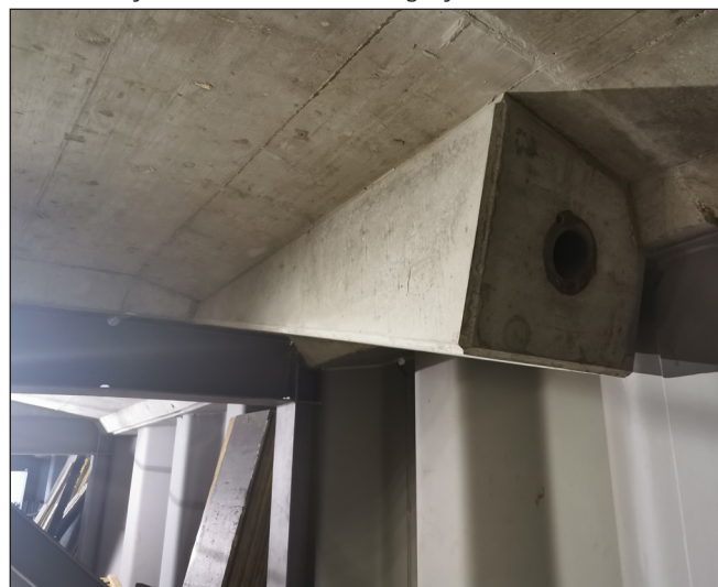
6. ábra: Pályalemeznel kialakított lehorgonyzó betontömb
