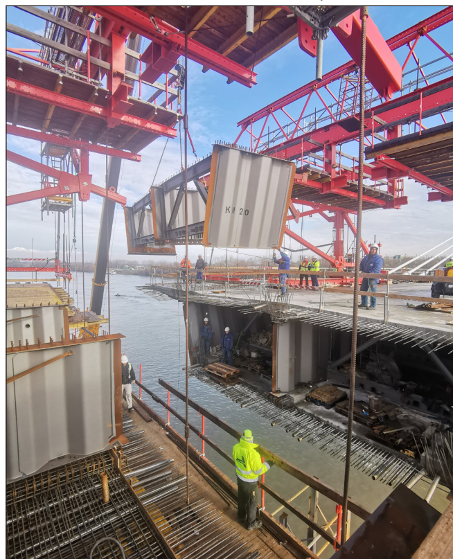
9. ábra: MM20 zárózom beemelése a mederközépen
