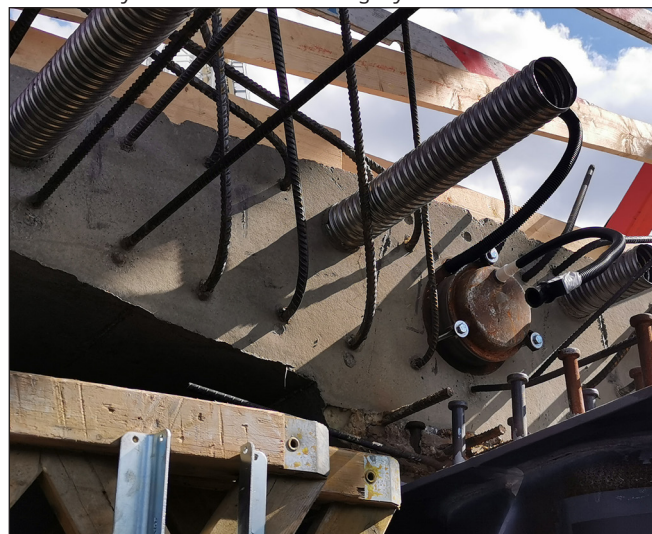
5. ábra: Pályalemez feszítőkábel lehorgonyzás
