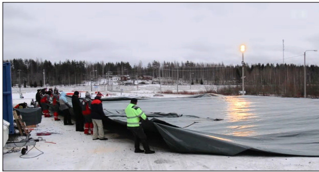
18. ábra: Ballon a „Jég-híd” felépítéséhez
