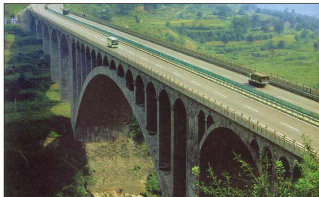
11d. ábra: Danhe híd felépítve
