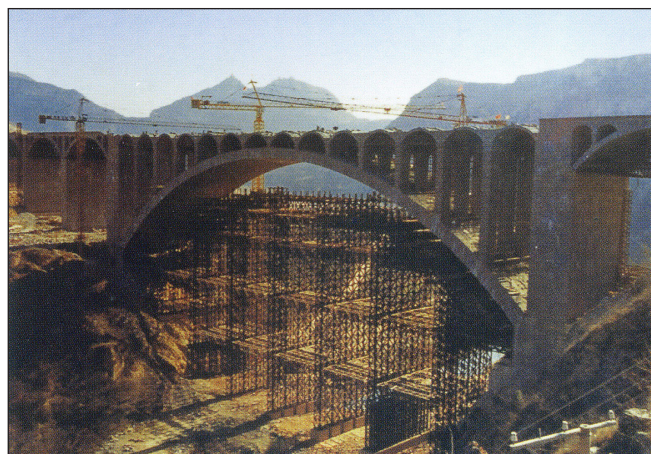
11c. ábra: A Danhe híd építése - acélvázszerkezet
