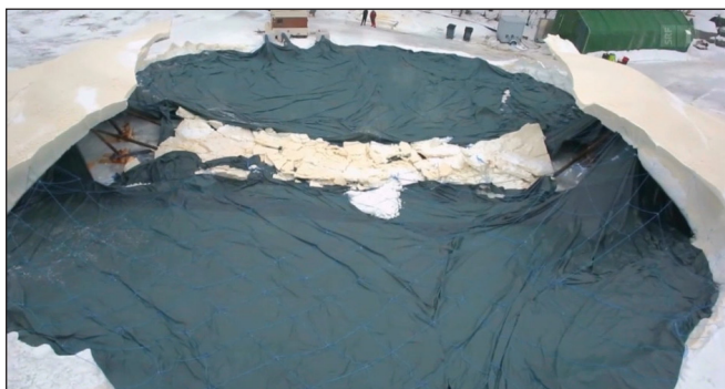
19. ábra: A „Jég-híd” összeomlása
