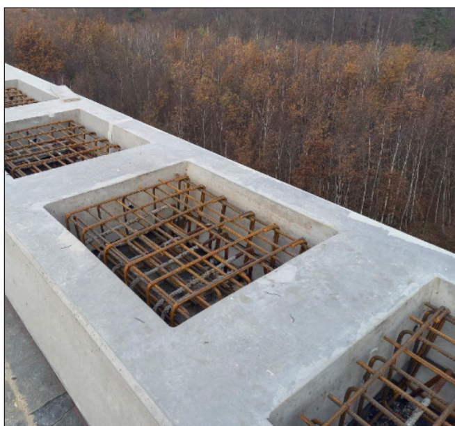
19. kép: Szegélyelem fészkek betonacél-szerelése
