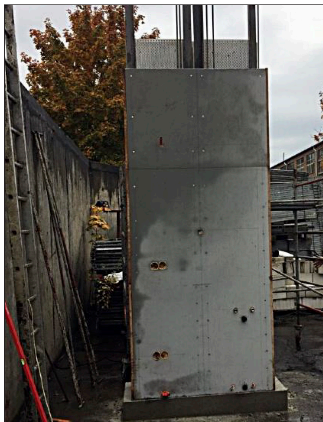
15. ábra: Falelem próbaszerelése
