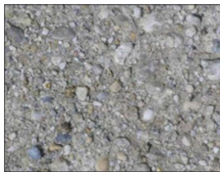
2/a ábra: 2005-ben CEM I 32,5 N-S cementtel készült takarmánytároló állapota 2010-ben (fényképezte: Kovács József DDC Kft.)
