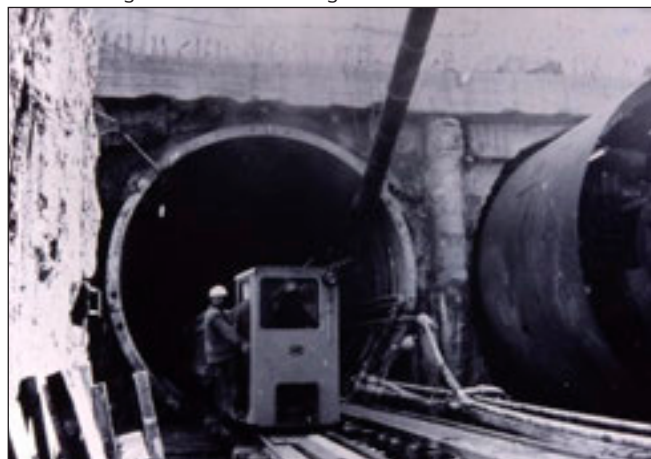
2. ábra: Belgrád Vracsar vasúti alagút
