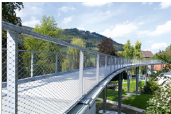
3. ábra: A világ jelenleg leghosszabb, textilbeton hídjája Albstadt-Lautlingenben
