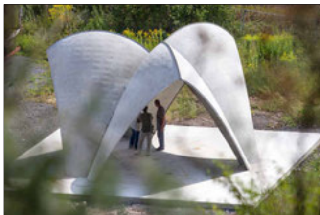
5. ábra: Karbonbeton pavilon Kahlában (Foto: Ulrich van Stipriaan)
