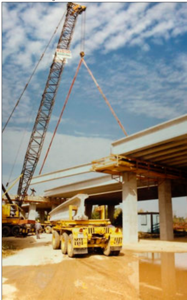
3. ábra: EHGT hídgerendák beemelése
