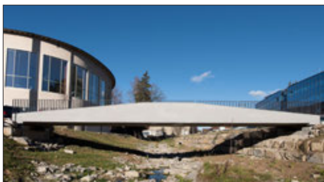
4. ábra: A világ első, csak karbonbetonból készült hídjája Albstadt-Ebingenben (Solidian)
