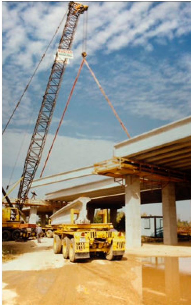
3. ábra: EHGT hídgerendák beemelése
