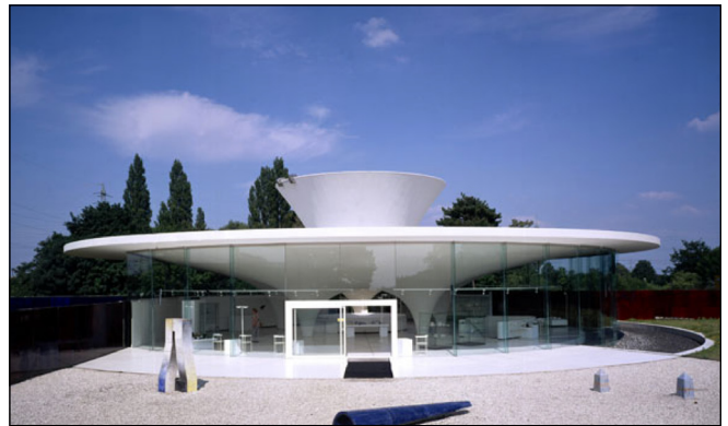
8. ábra: Hartyahéj: Keramion Frechen/Köln 1970, Neufert/Polónyi (fotó: Polónyi)
