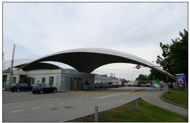
7. ábra: Bubble shell: Deitinger Süd Rasstätte. 1968, Heinz Isler (fotó: Genzel)
