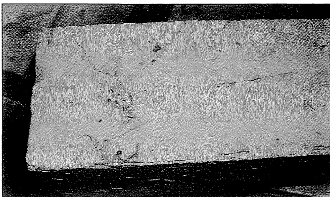
14. ábra: Makroszállal erősített beton (500°C-os hőterhelés)
