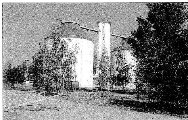
4. ábra: A Győrben megvalósult iszaprothasztók képe
