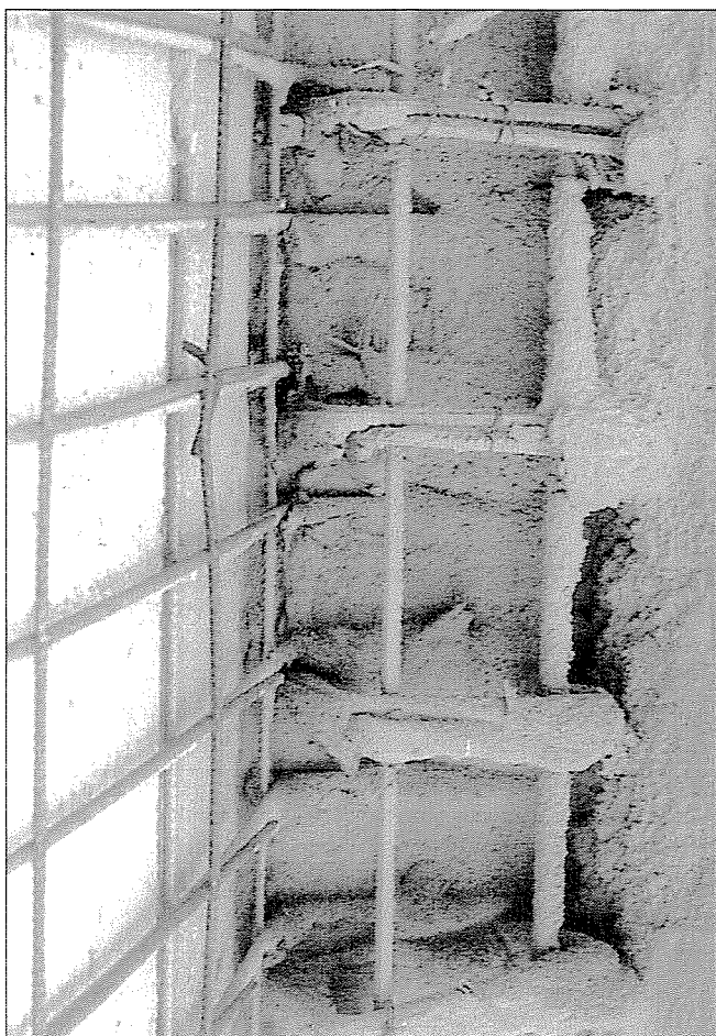
6. ábra: A hegesztett háló bekötése
