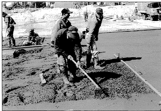
5. ábra: A betonozási egységek lesimítása
