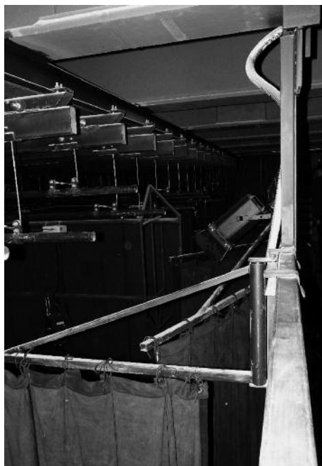
Panoráma függönyök a munkakarzat szélén
